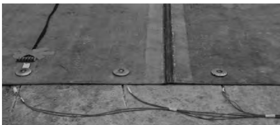
Fig. 14. Strain gauge placement on anchoring bolts Rys. 14. Umieszczenie tensometrów w obszarze kotwienia
